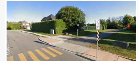
Traverse piétonnière sécurisée
